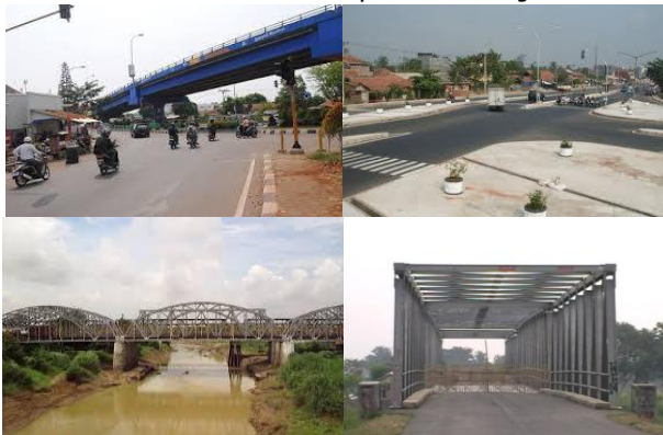
Gambar 13. Infrastruktur di Kabupaten Karawang
